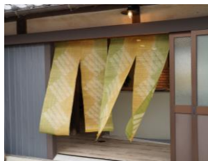
古民家を改装中!
